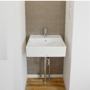
Aタイプ 角型洗面台 500×450 シングルレバー混合水栓 床排水
